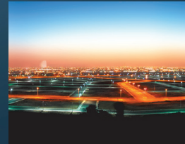
تنفيذ البنى التحتية والخدمات
