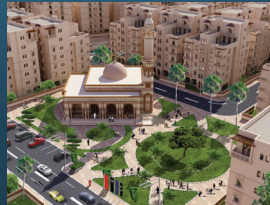
إنشاء المشاريع السكنية والتجارية
